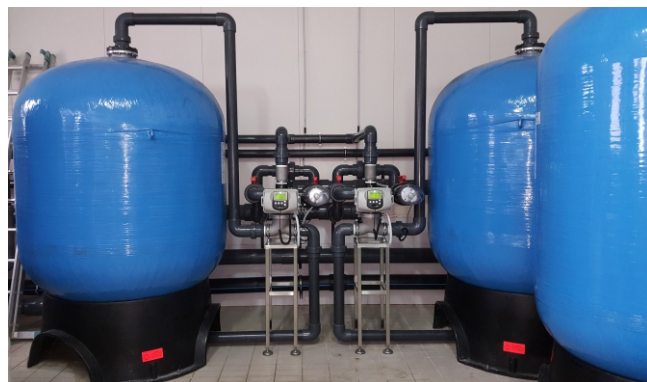
Automatski filteri sa aktivnim ugljem u paralelnom radu sa Clack WS3CI upravljačkim ventilima
