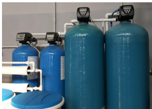
Deferizator, filter sa aktivnim ugljem i duplex omekšivač u predtretmanu RO uređaja
